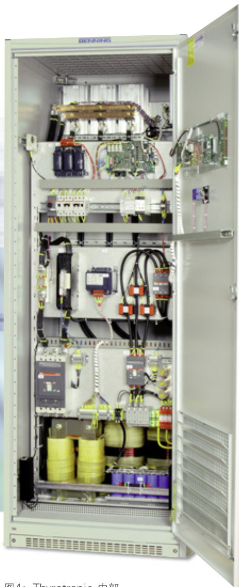
图4: Thyrotronic 内部
